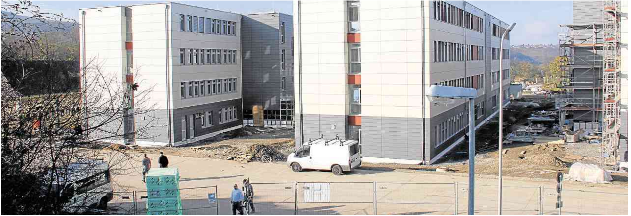
Mitte Februar 2015 sollen die ersten beiden in modularer Systembauweise erstellten Gebäude bereits bezugsfertig sein.
